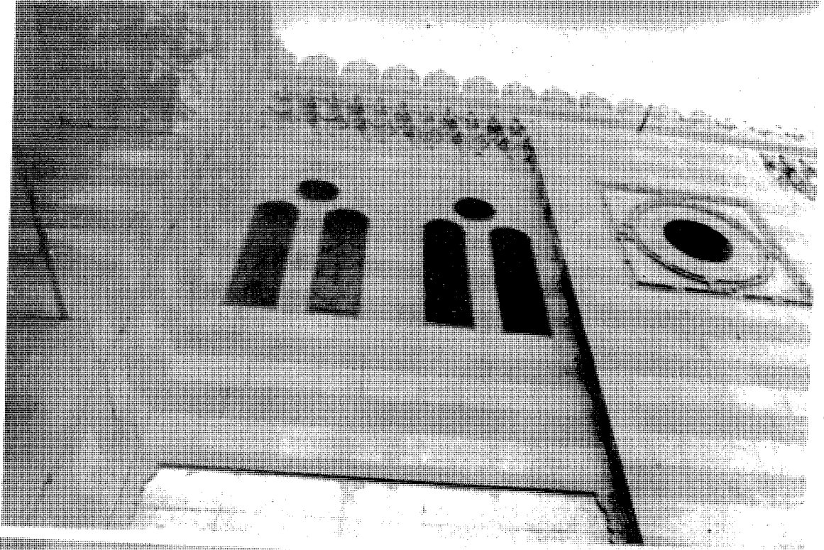
لوحة (٢٠١) الشرفات التي تملو الواجهة الرئيسية لمدرسة بيبرس الخياط التي تشغل الضلع الشرقي للمدرسة كما يظهر الجزء المتوسط الذي يشغله الجزء الأعلى من الحنية ، التي تشغلها نافذتان قنديليتان
